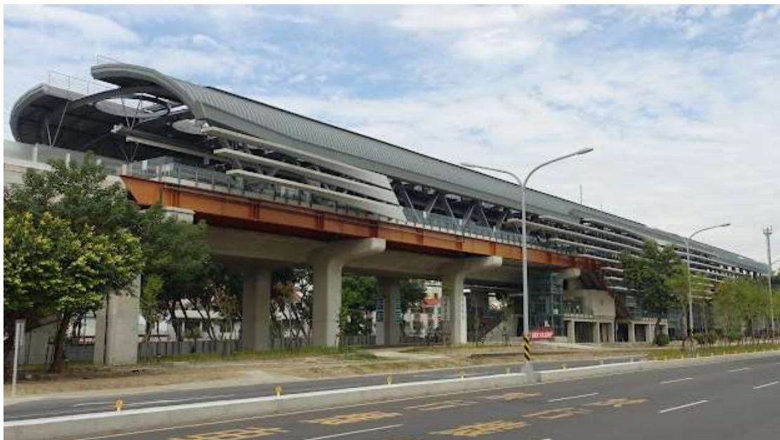
台中捷運 精武站
